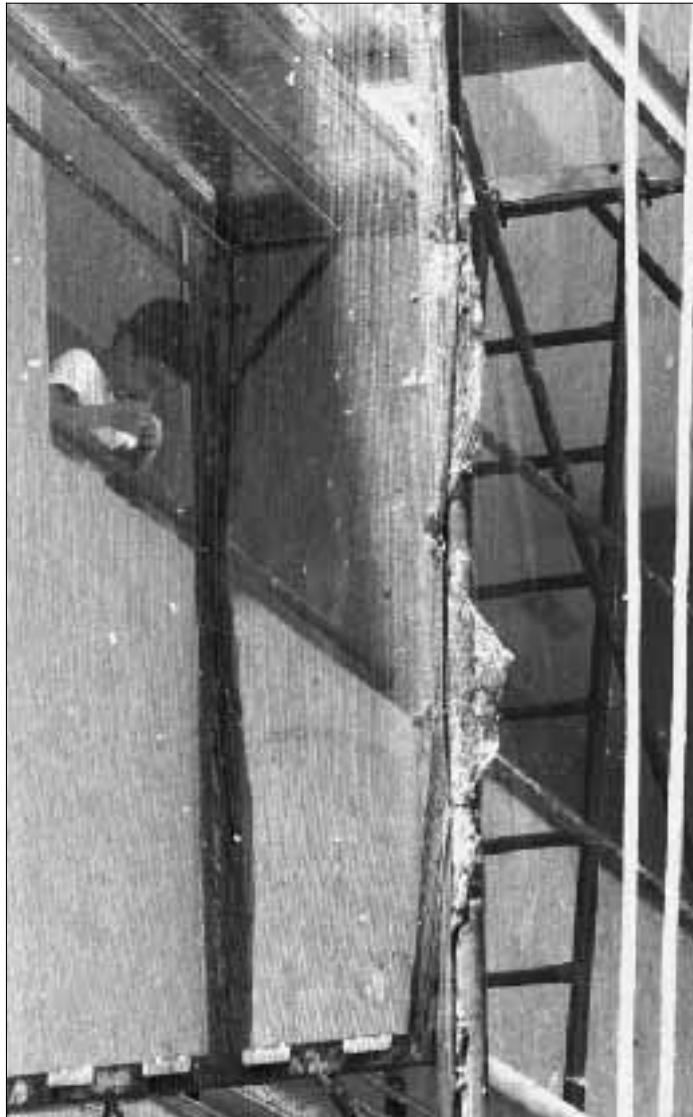
L'impalcatura nel parco Vesuvio ad Ercolano da dove è caduto il sedicenne. Fusco/Ansa
