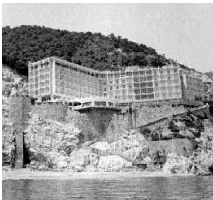
Il complesso alberghiero di «Fuenti»
