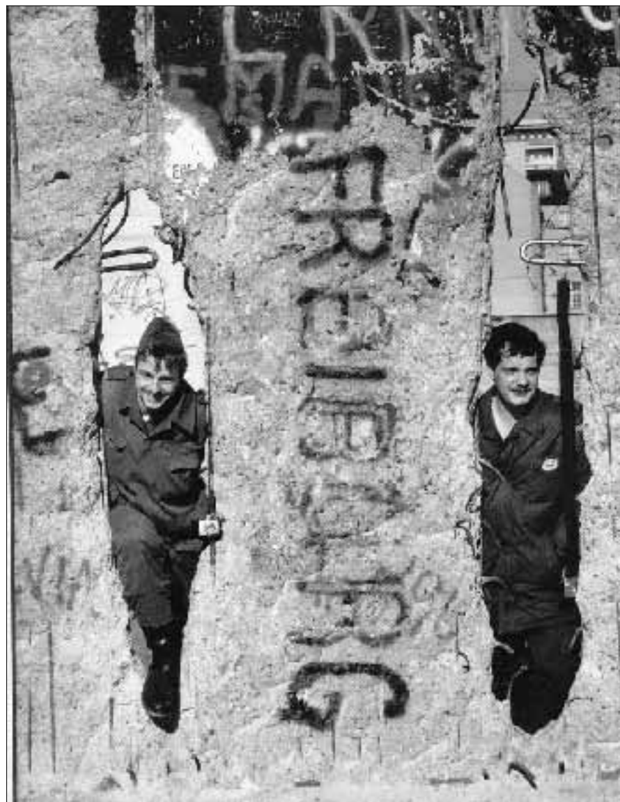
1989: buchi nel muro di Berlino. In alto, nove anni dopo, cantieri a Postdamer Platz per la ricostruzione di Berlino capitale
