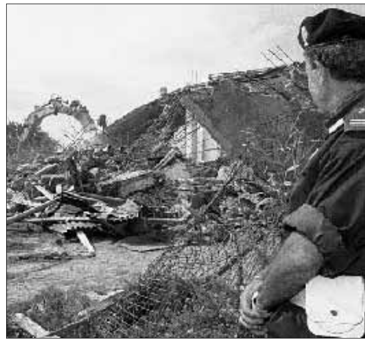
La demolizione delle case abusive nell'oasi del Simeto a Catania. S. Ragonese/Ansa
