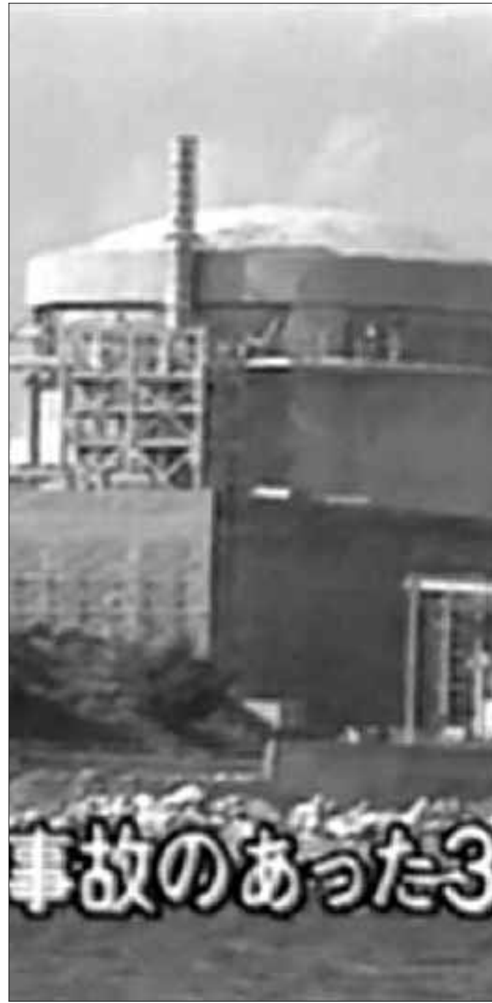
Una immagine televisiva della centrale coreana
