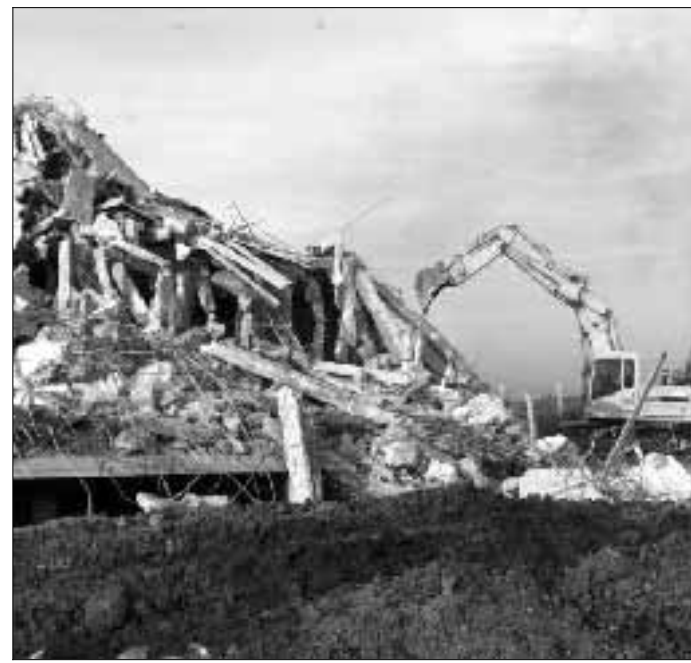
La demolizione di una villetta alla periferia di Roma M. Brambati/Ansa
