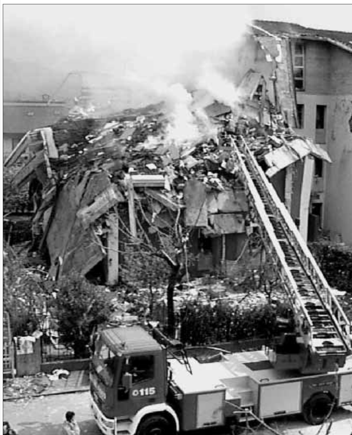
BRESCIA Un'esplosione, dovuta con ogni probabilità ad una fuga di gas, ha fatto crollare ieri una palazzina a Bovezzo, in provincia di Brescia. Tre le vittime accertate, un sottufficiale dell'Aeronautica, una donna e uno studente. Due i dispersi, tra i quali un bambino di sette
