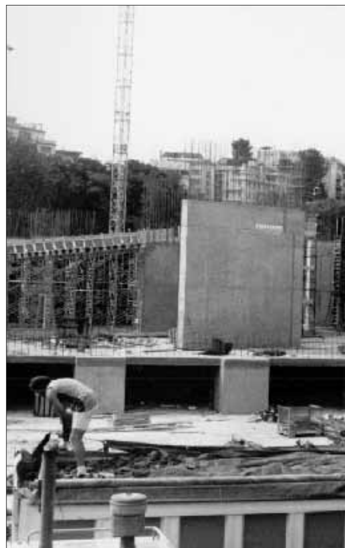
Lavori in corso a Roma per realizzare l'auditorium progettato da Renzo Piano (nella foto piccola)
