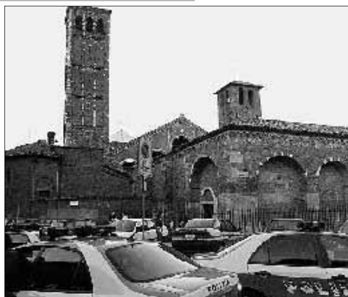
Volanti della polizia davanti alla chiesa di S. Ambrogio all'interno della quale sono state trovate due bottiglie incendiarie
