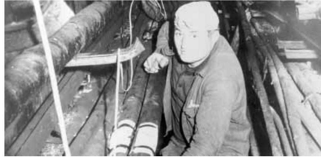
Un operaio della manutenzione dei cavi telefonici
