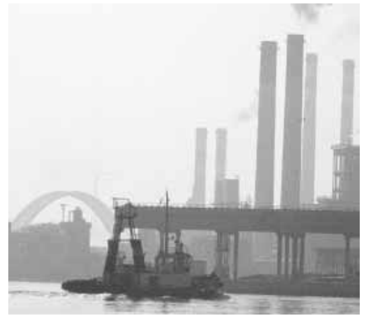
Gli stabilimenti del petrolchimico di Porto Marghera
