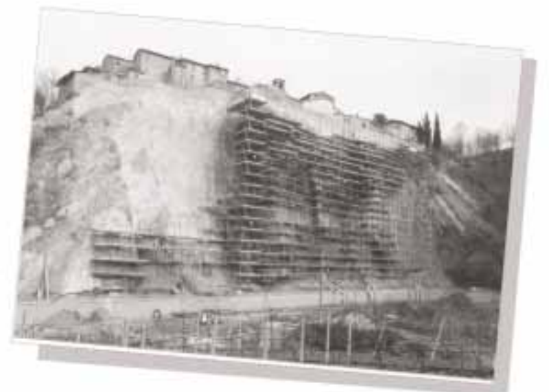
Consolidamento parete rocciosa a salvaguardia dell'abitato di Linaro (FO) (Ancoraggi - tiranti e spritz-beton)
