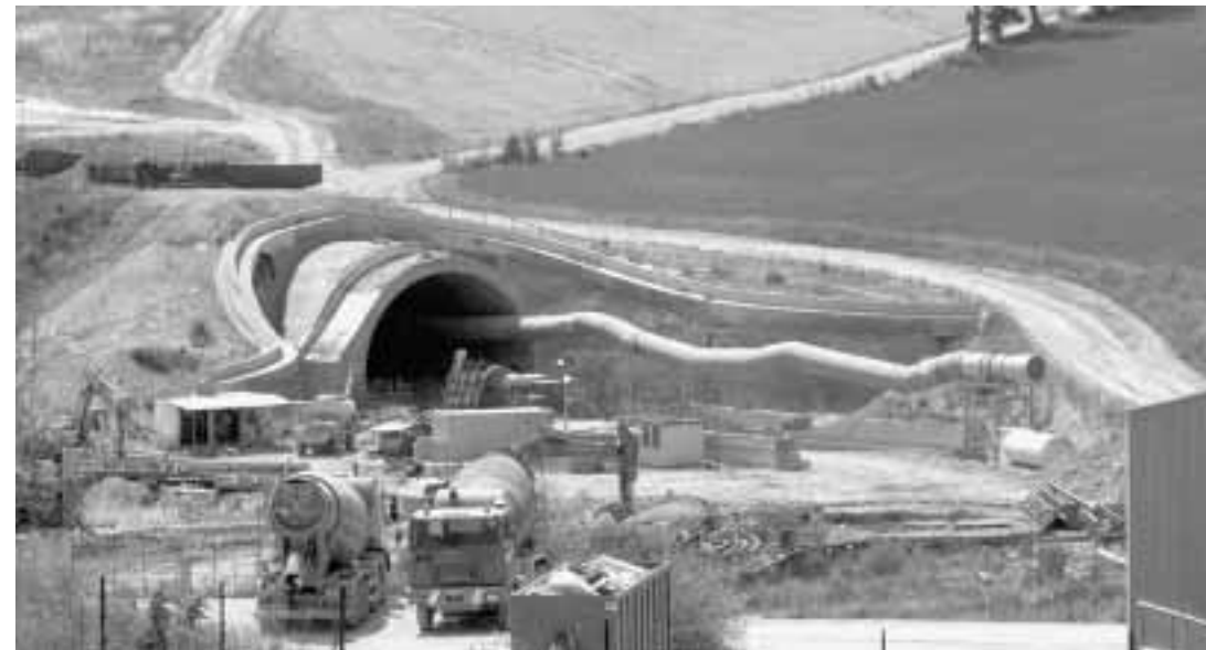
Una galleria in costruzione nel Mugello in Toscana
