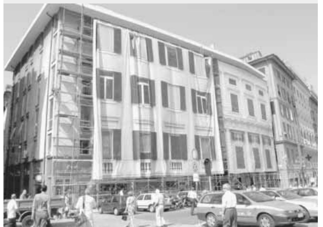
Una immagine dell'edificio anni 60 criticato da Berlusconi durante uno dei sopralluoghi compiuti a Genova: la facciata dell'edificio è stata mascherata con dei teloni stampati che richiamano i motivi architettonici del palazzo Ducale.
