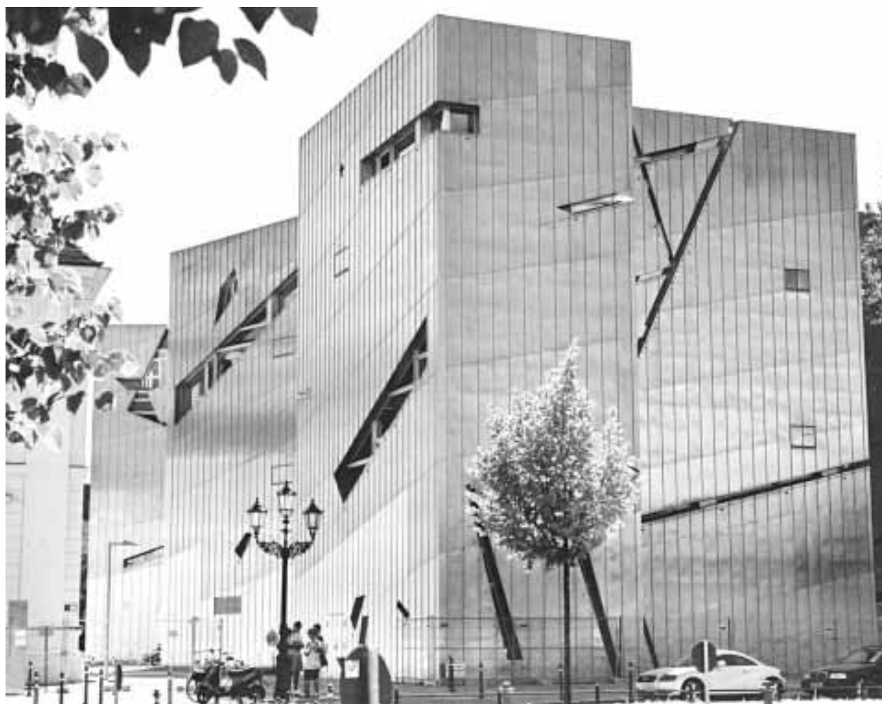
Una veduta esterna del Museo ebraico che s'inaugura oggi a Berlino. Sotto l'architetto Daniel Libeskind e, in basso, un interno dell'edificio
