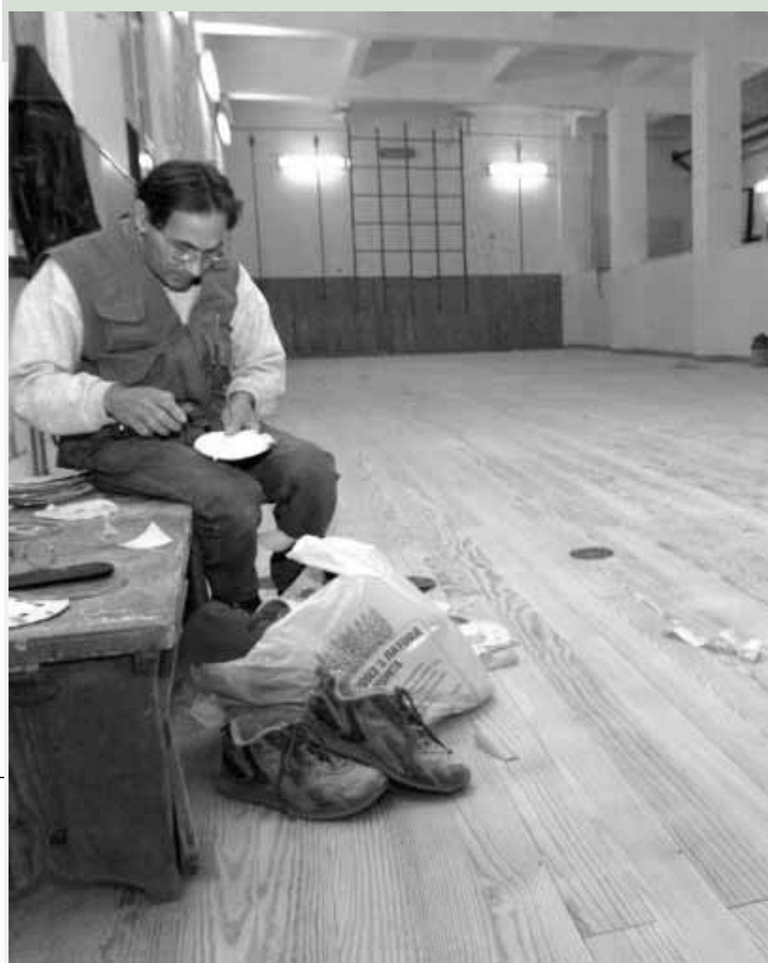
La palestra della scuola Diaz in fase di ristrutturazione. Qui avvennero i primi scontri
