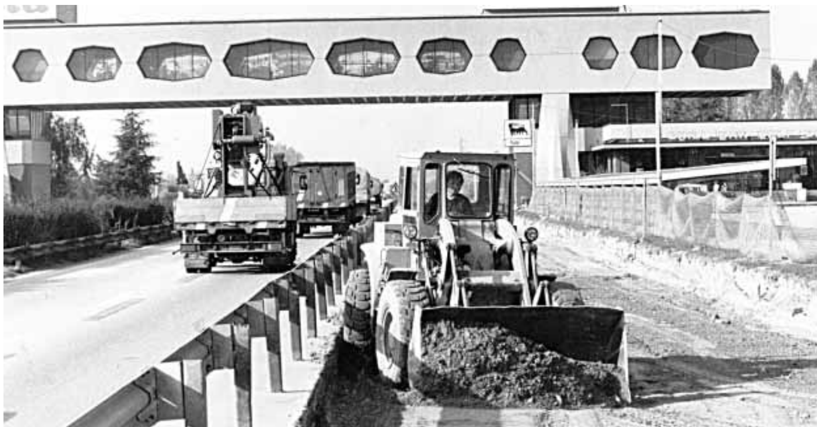
Lavori autostradali dell'Anas. In basso il ministro Pietro Lunardi
