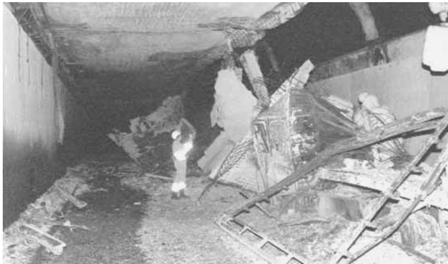
Due immagini dell'interno della galleria del Gottardo
