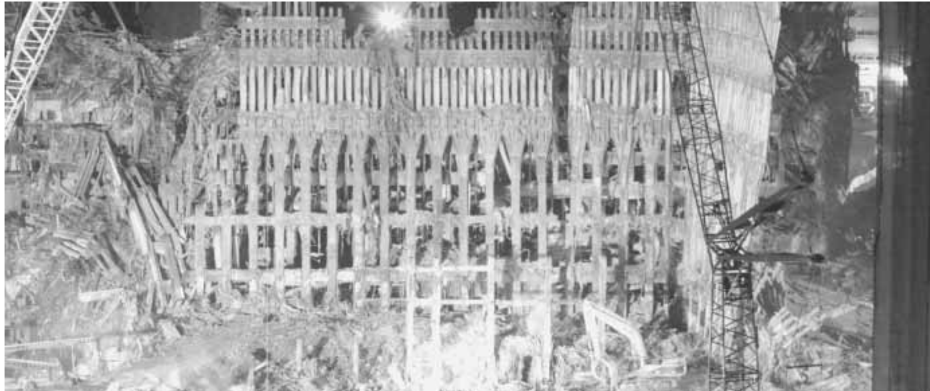
Continuano senza sosta i lavori di recupero sulle Twin Towers
