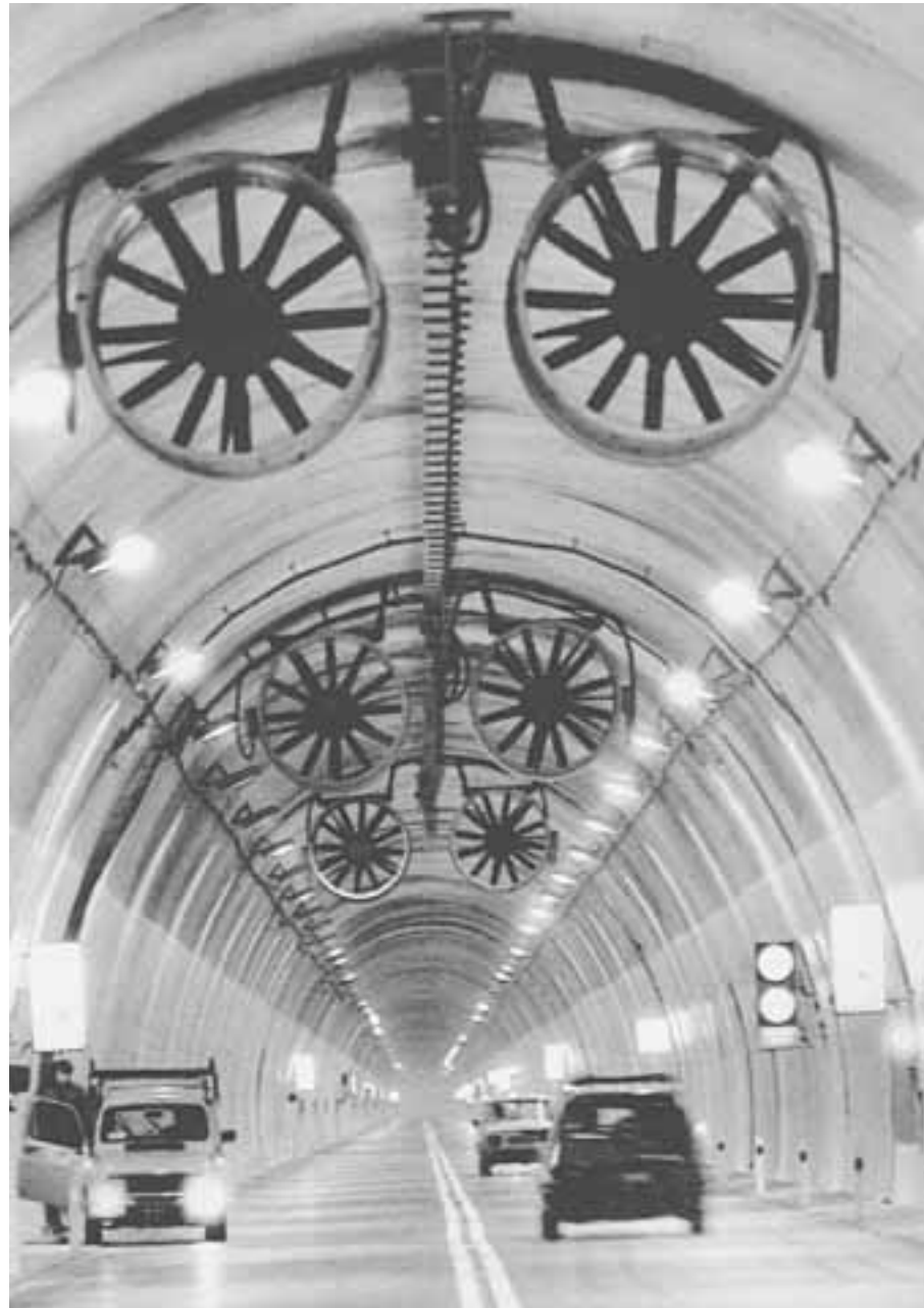
La galleria del traforo del Gran Sasso
