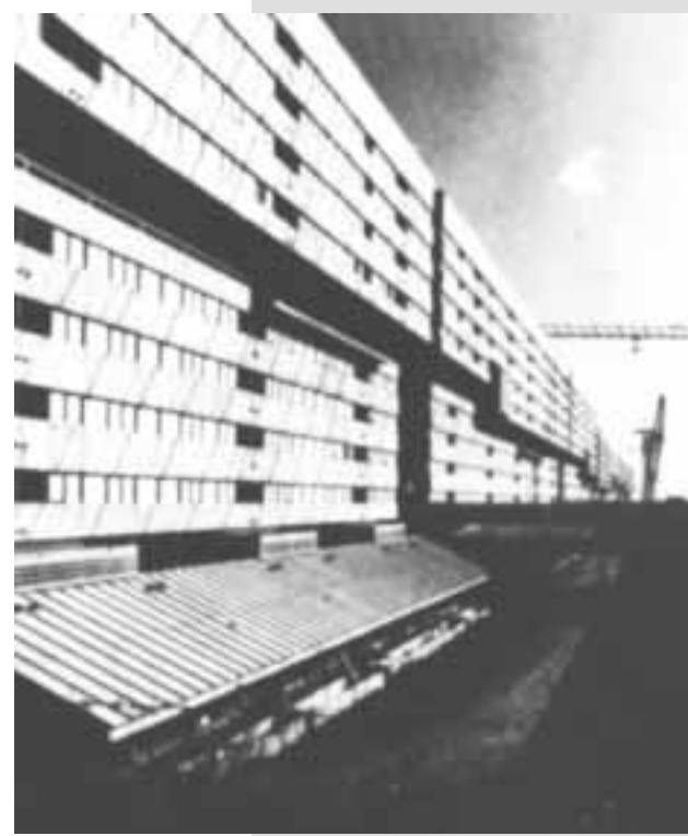
Qui sopra una veduta del Corviale a Roma. Al recupero di questa struttura architettonica e urbanistica sarà dedicato un convegno venerdì prossimo
