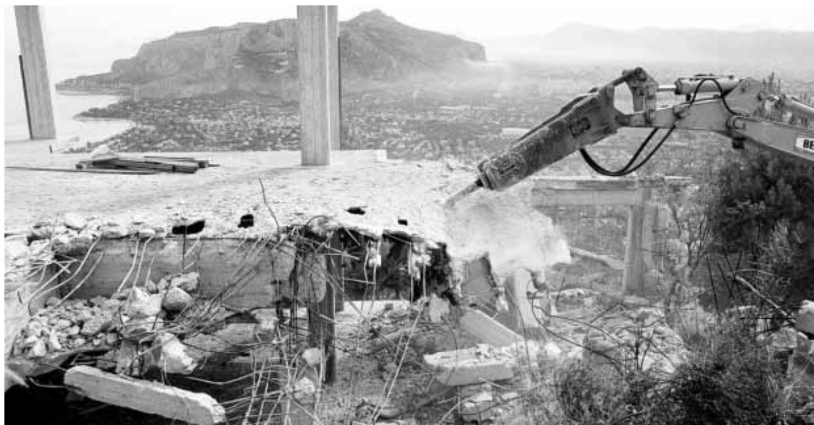
Demolizioni di case abusive in Sicilia
