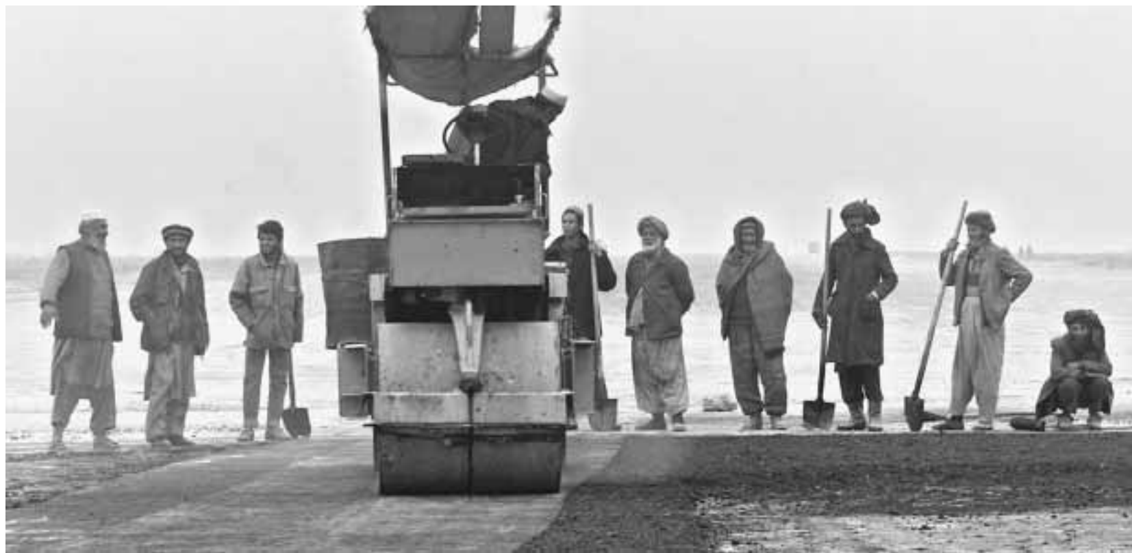
I lavori per la ricostruzione dell'aeroporto di Kabul
