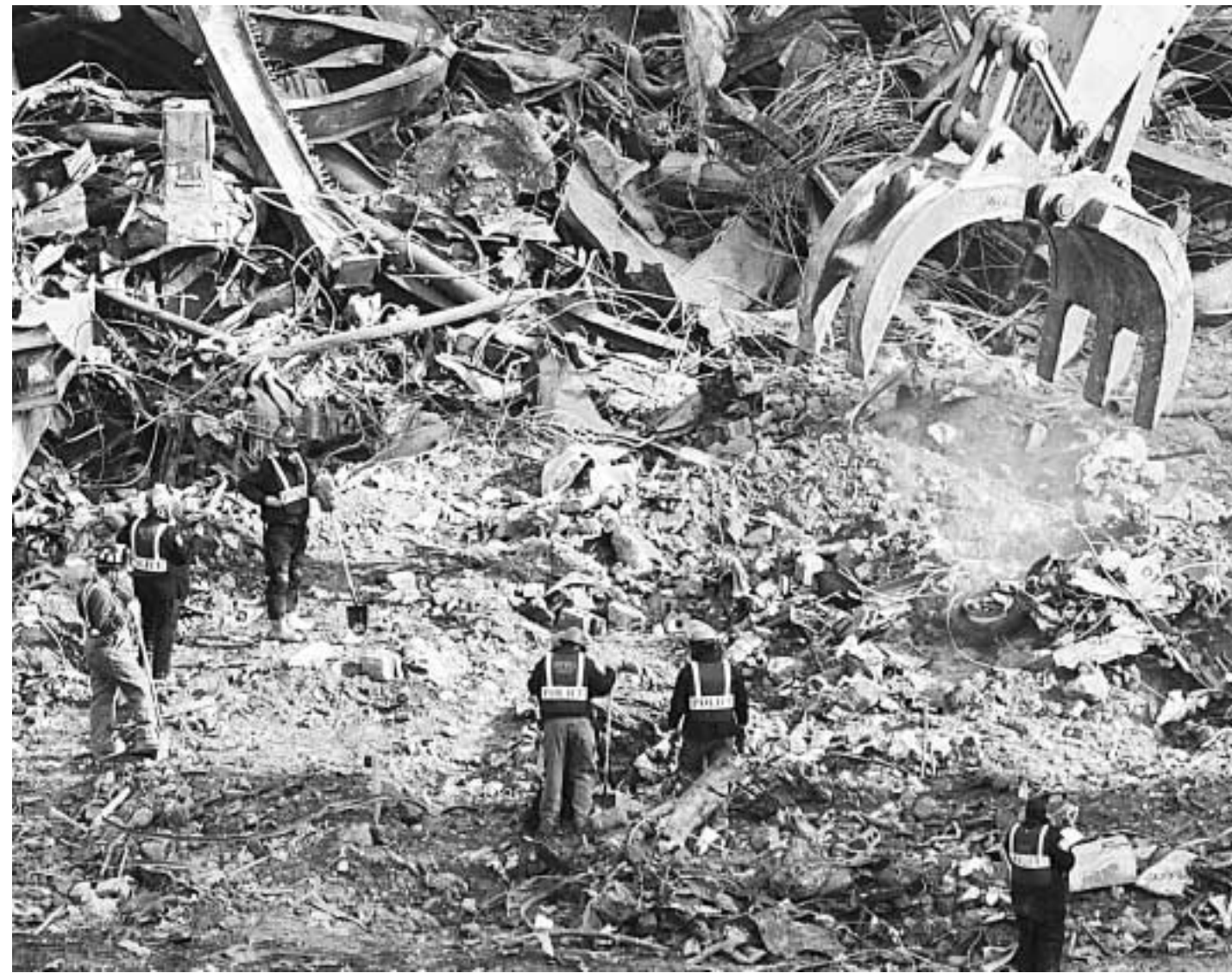
I lavori presso le macerie delle Torri gemelle a New York sotto l'ex sindaco Rudolph Giuliani
