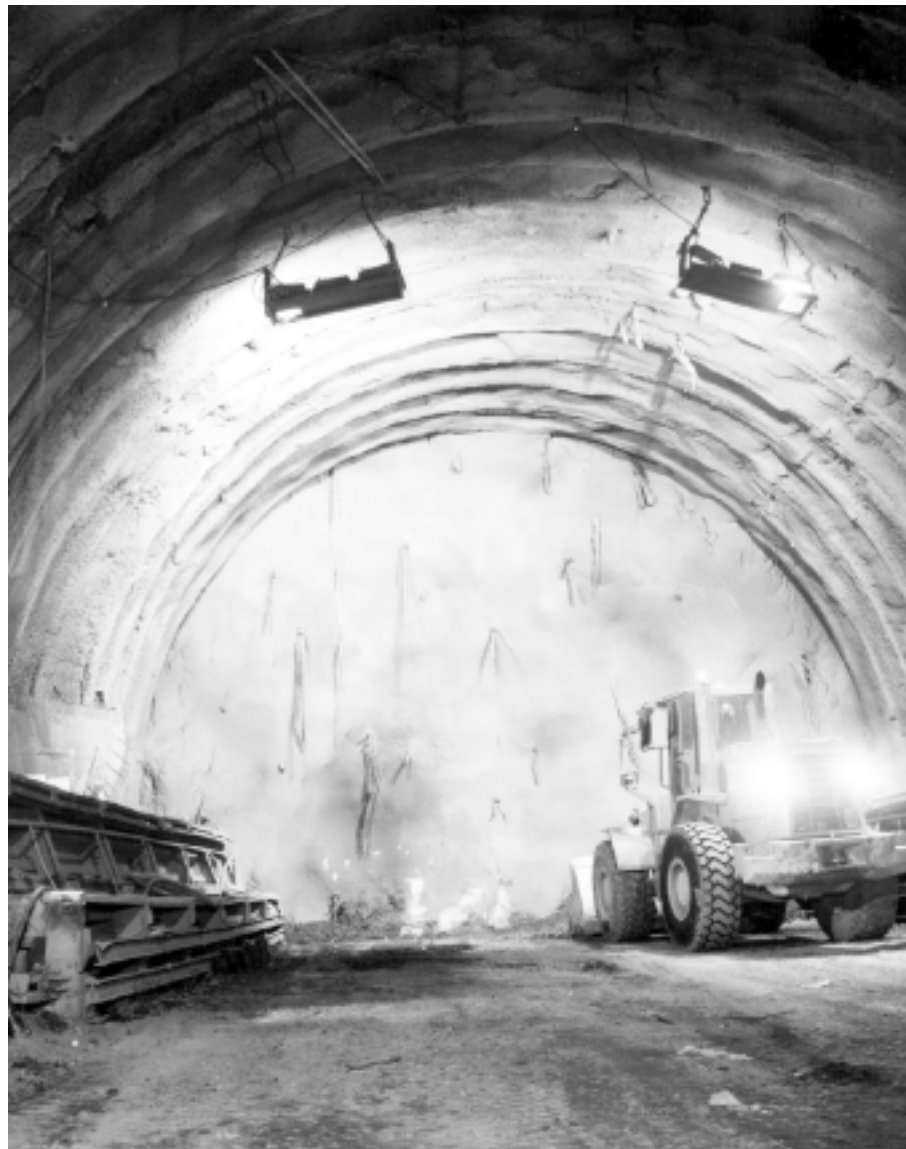
I lavori per l'alta velocità ferroviaria
