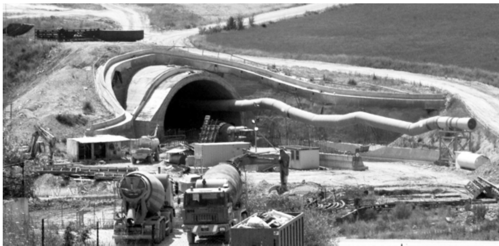
Il cantiere della Variante di valico in Toscana
