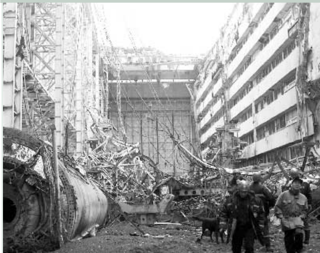
I soccorritori hanno recuperato i corpi di sei degli otto lavoratori, morti nel crollo dell'edificio 112, nella base spaziale russa di Baikonur in Kazakistan.
