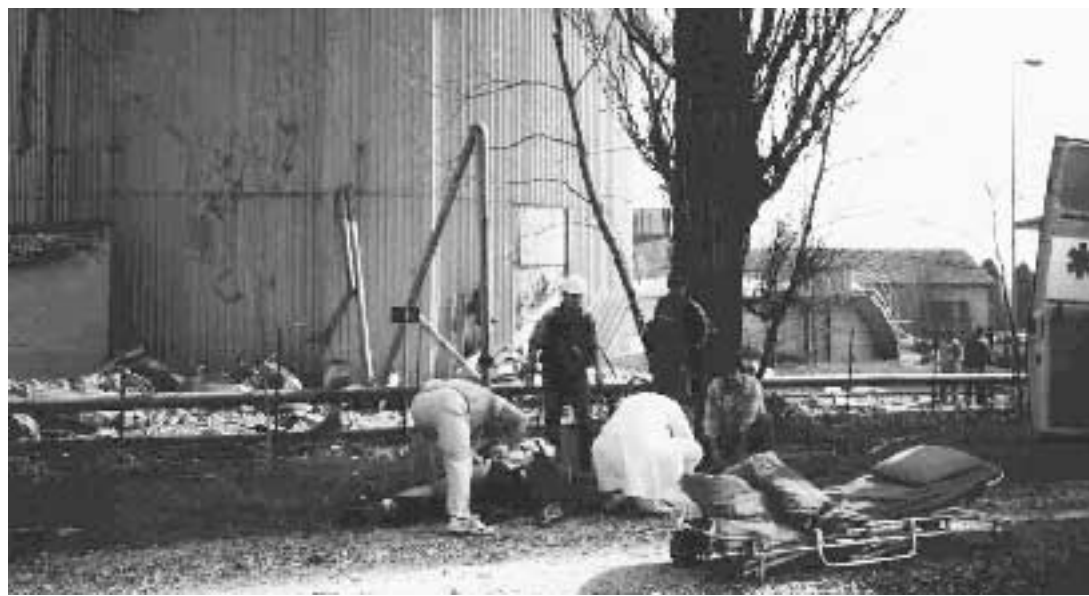
Un operaio rimasto ucciso qualche tempo fa per lo scoppio di un impianto di biogas
