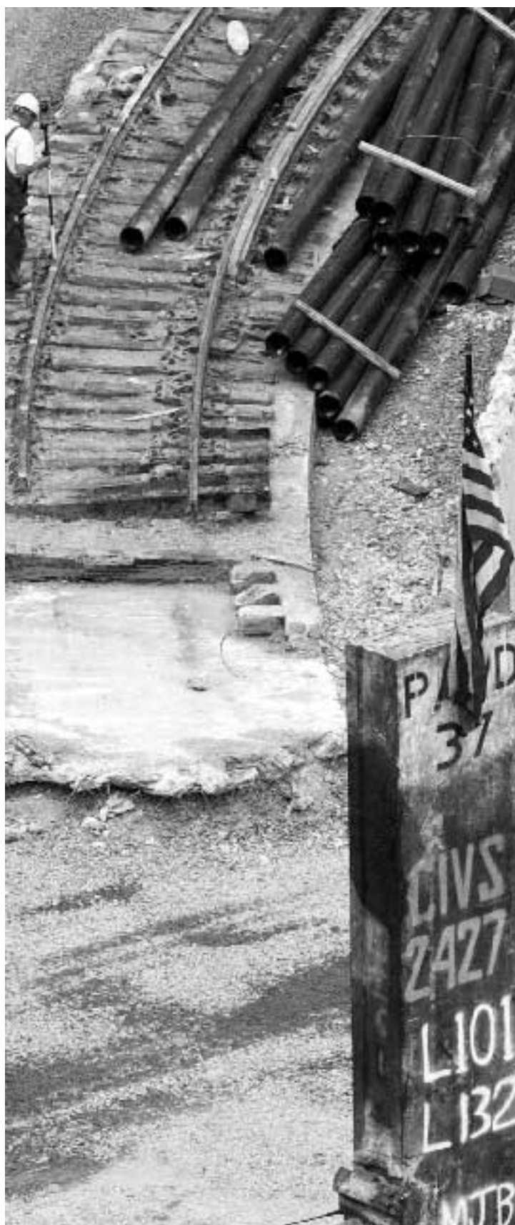
Un tratto di binari della metrò che transitava sotto le torri gemelle
