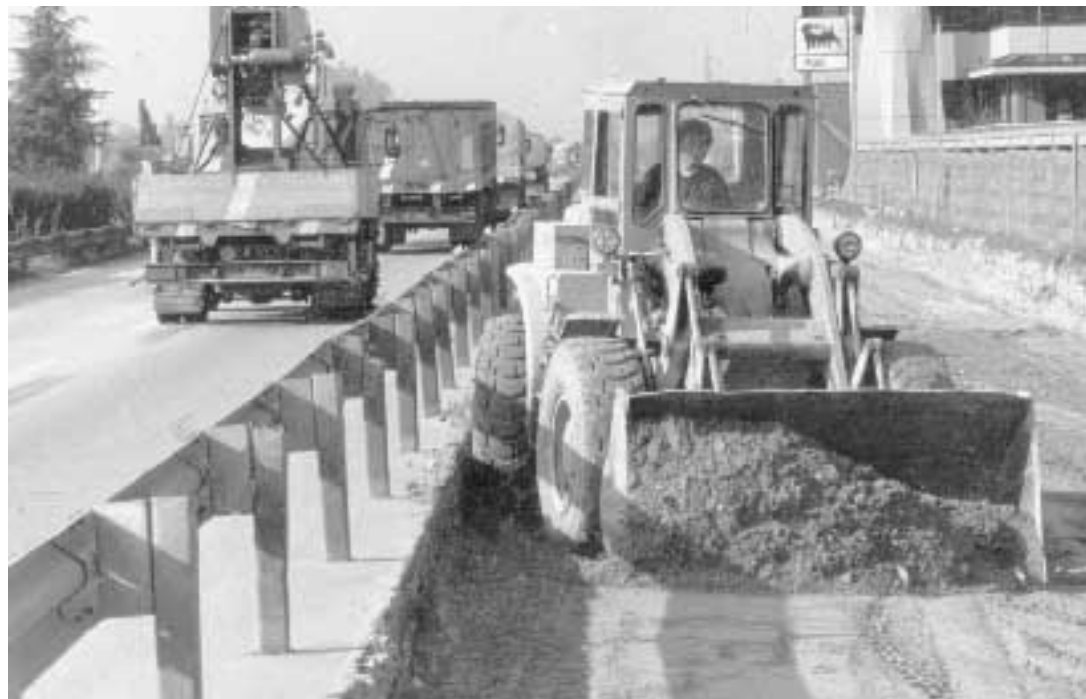
Lavori in corso in autostrada
