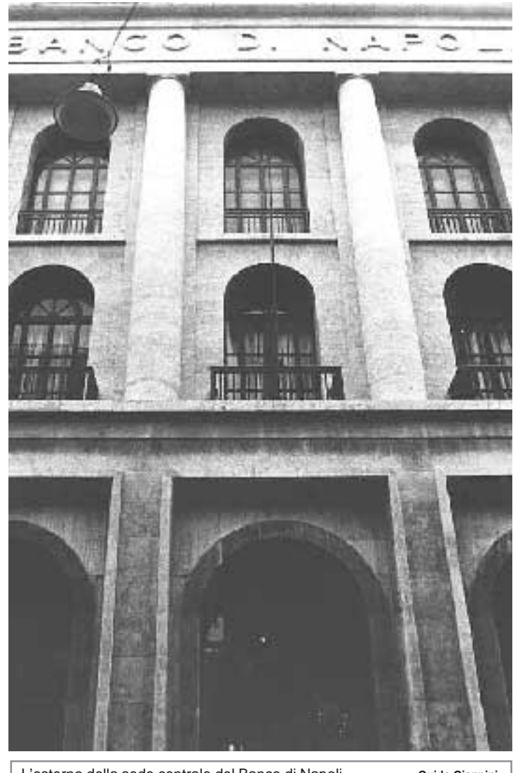
L'esterno della sede centrale del Banco di Napoli
