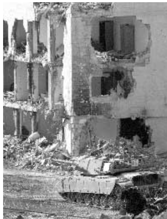
Edifici distrutti dall'esercito israeliano a Ramallah
