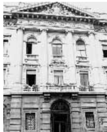
L'esterno della Banca Commerciale
