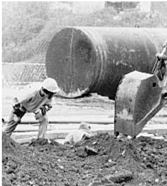
Un operaio in un cantiere
