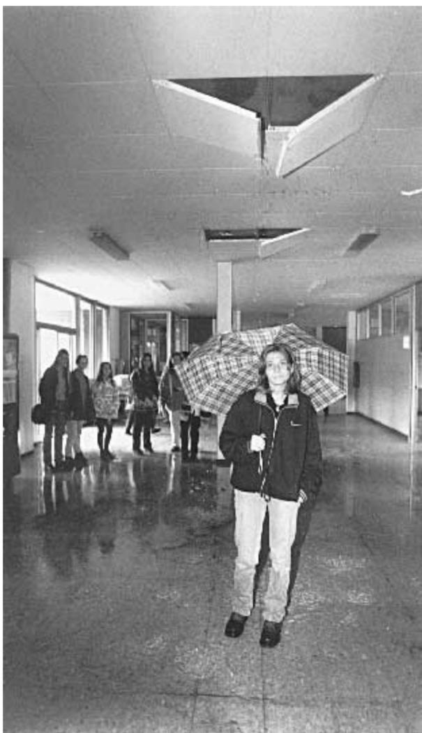
un terzo piano, ma dato che il terreno sottostante è solido quanto la sabbia, adesso ci ritroviamo in questa situazione: la scuola sprofonda di non so quanti centimetri all'anno e sul tetto abbiamo una scala che punta verso il cielo e che avrebbe dovuto portare al terzo piano...
