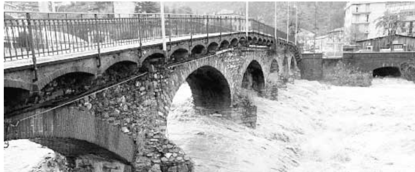
Situazione di emergenza con numerosi allagamenti a Genova Luca Zennaro/Ansa
