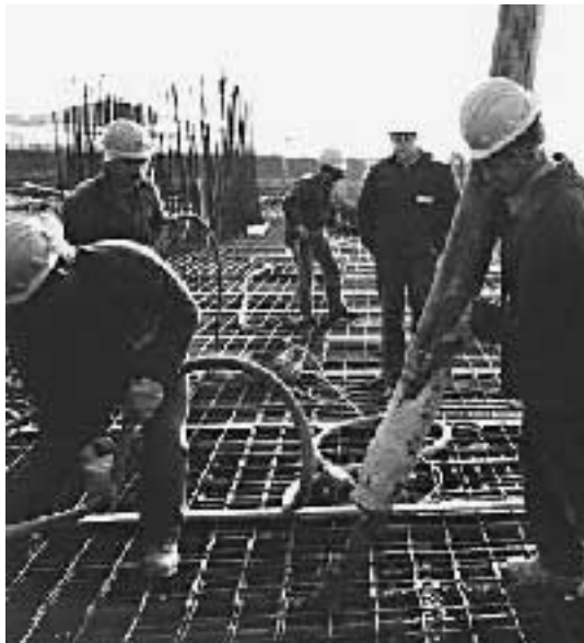
Operai di un cantiere
