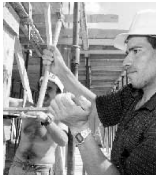
Operai al lavoro in cantiere Daniel Dal Zennaro/Ansa
