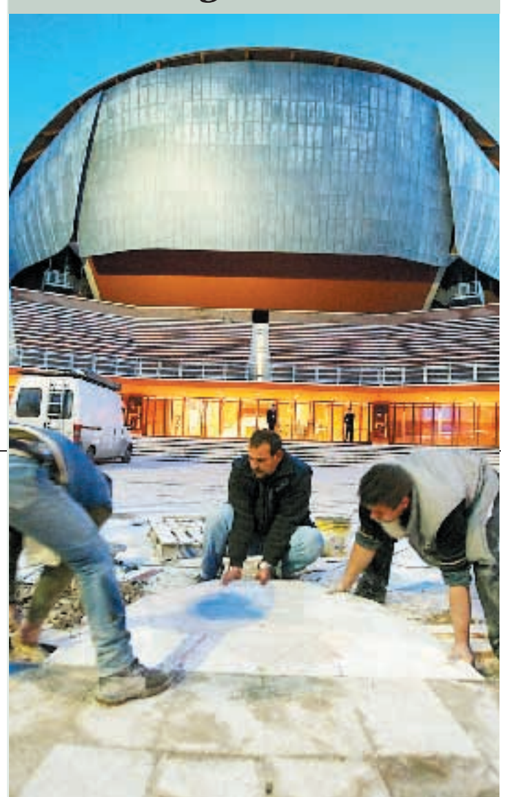
Ultimi lavori al nuovo Auditorium di Roma
