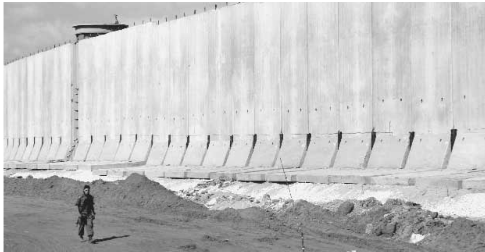
Un'immagine della barriera in costruzione lungo il confine tra Israele e la Cisgiordania. Nackstrand/Ansa
