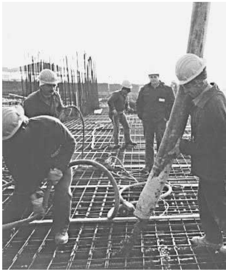
Operai in un cantiere edile
