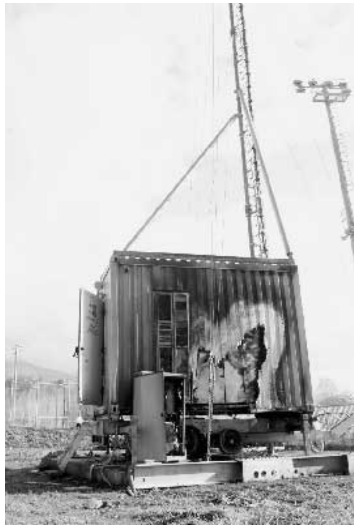
La cabina della telefonia mobile incendiata a Marina di Pietrasanta. Franco Silvi/Ansa
