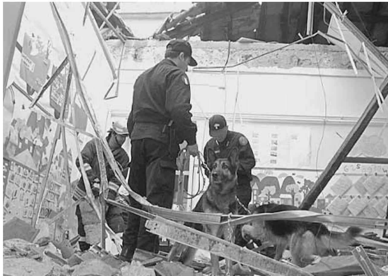
I soccorsi nell'asilo comunale di Montelibretti, vicino Roma, dove è crollata una parte del tetto
