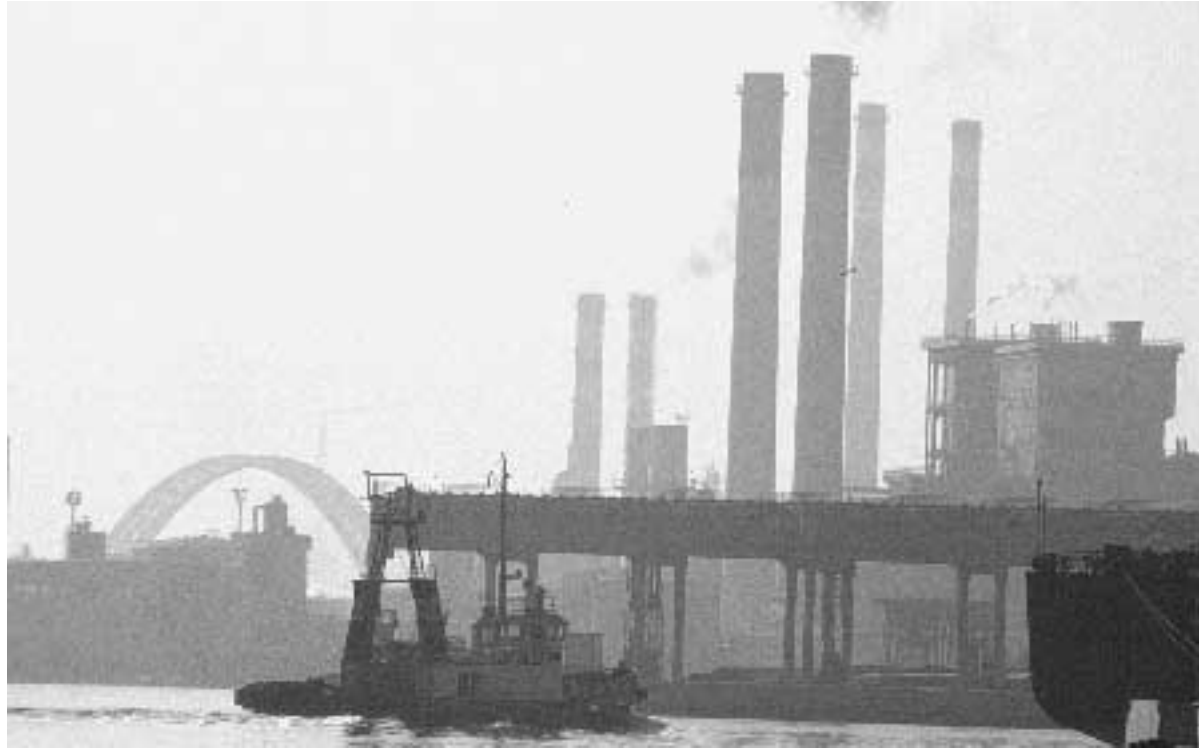
Gli impianti del Petrolchimico di Marghera
