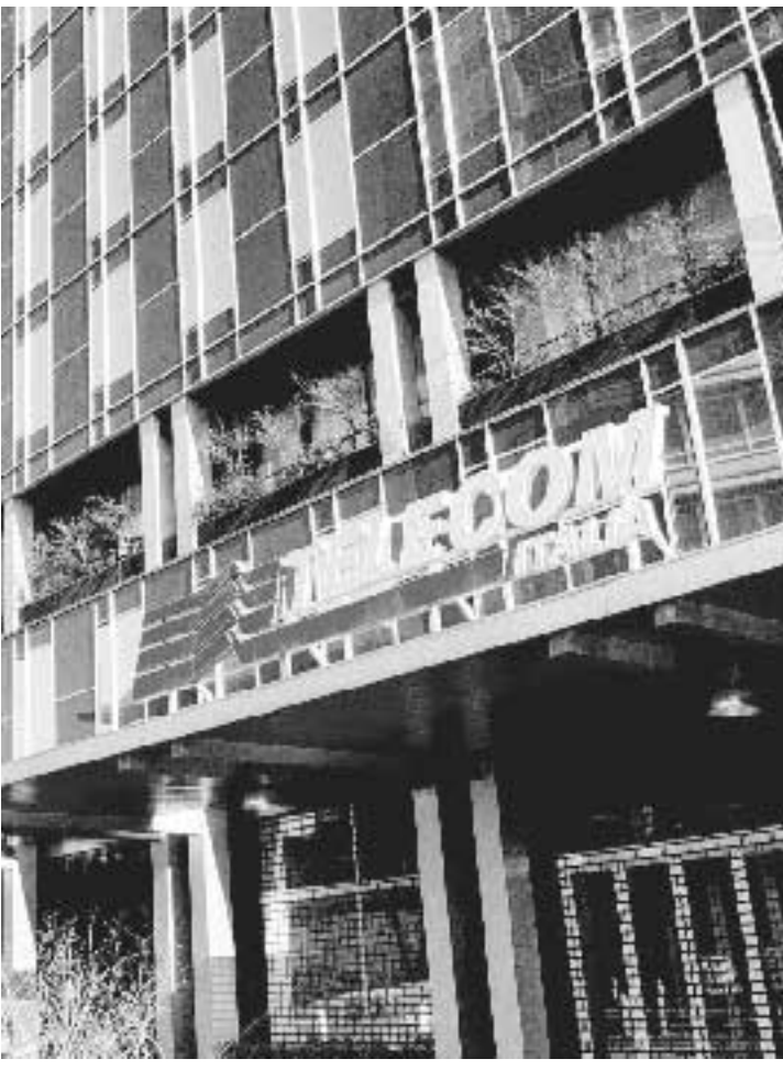
La sede della Telecom Italia a Milano
