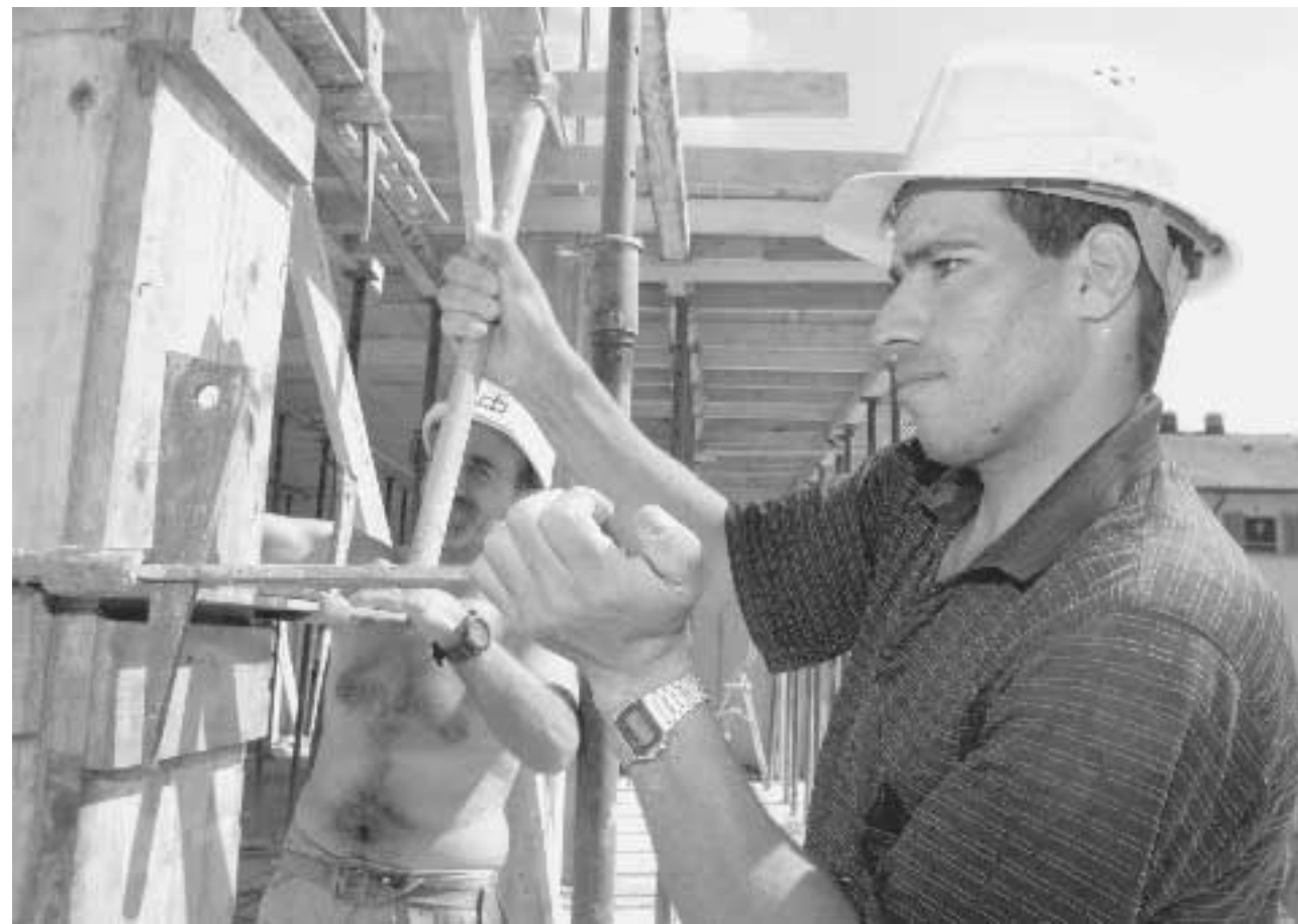
Operaio immigrato al lavoro in un cantiere di Milano
