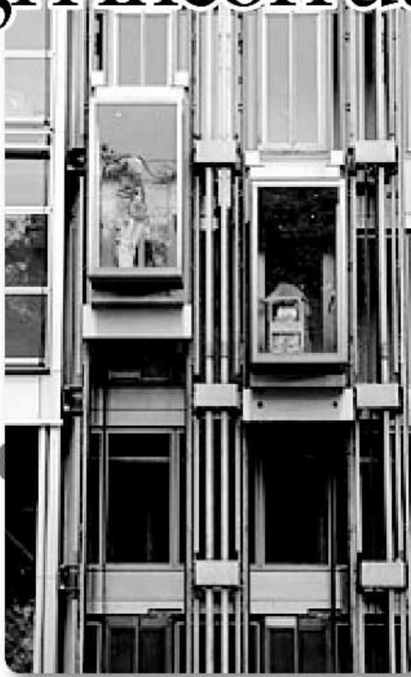
Particolare di una parete esterna della Fondation Cartier a Parigi, progettata da Jean Nouvel. Sotto: André Breton
