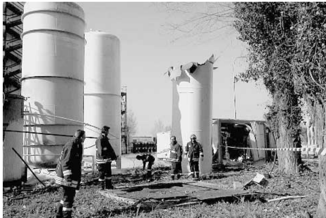
La fabbrica di vernici vicino Napoli dove si è verificata l'esplosione
