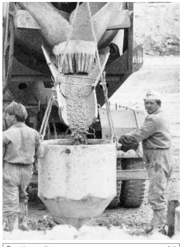
Operai in un cantiere Zolli
