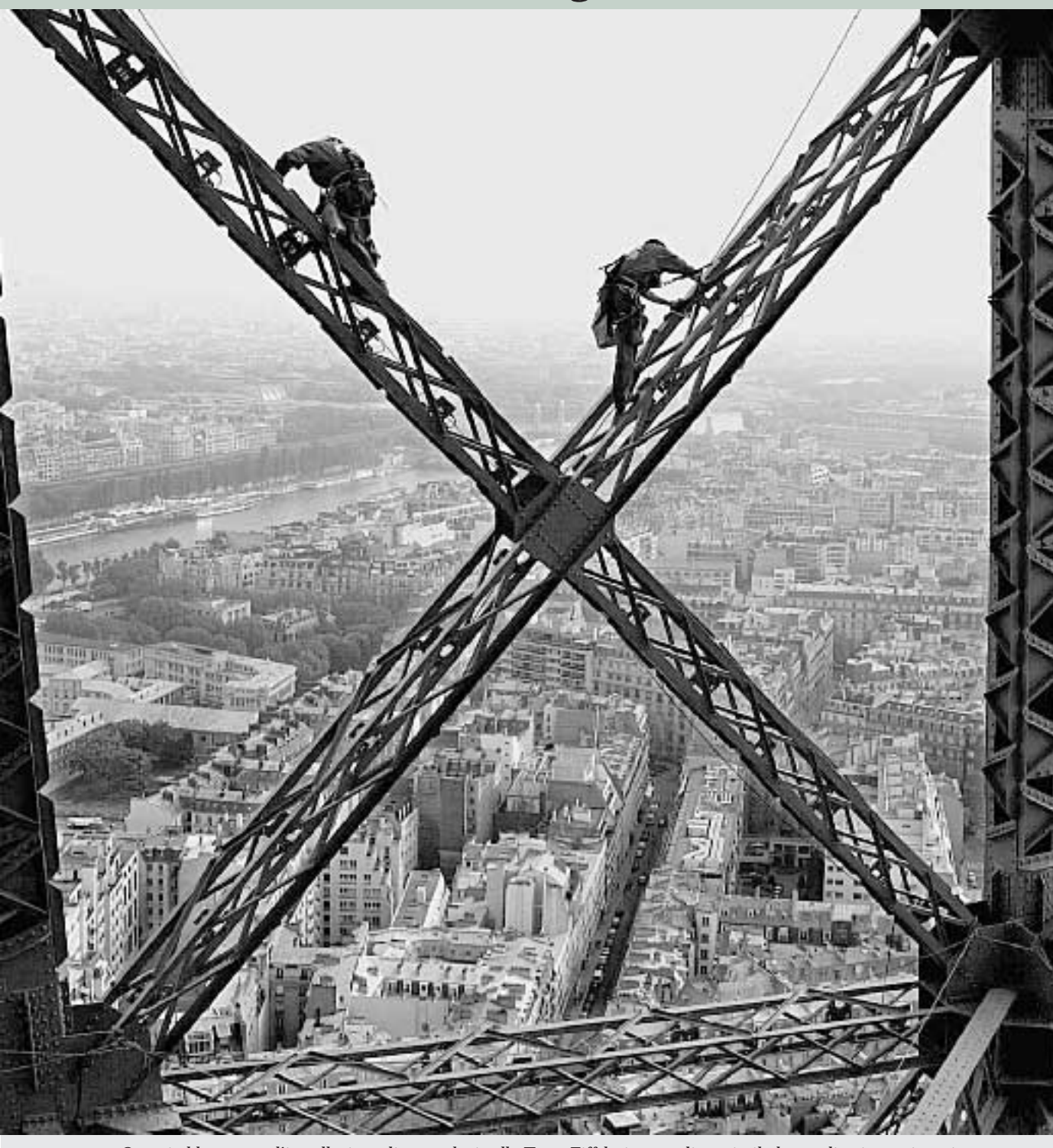
Operai al lavoro per l'installazione di nuove luci sulla Torre Eiffel: si tratta di ventimila lampadine intermittenti
