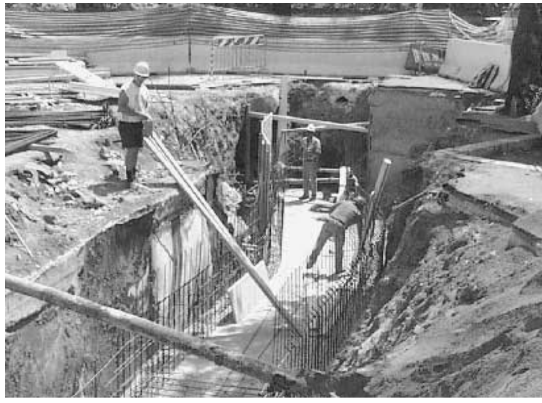
Operai al lavoro in un cantiere stradale
